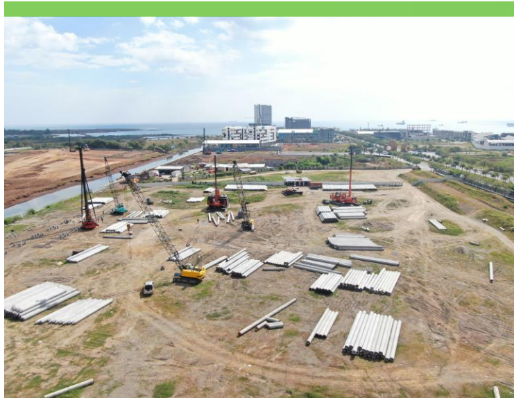
Pembangunan Ciputra World Mall (CWM) Makassar
